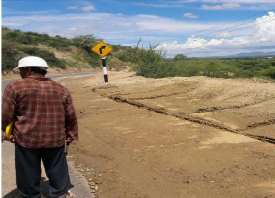
1. VISTA DE RELLENO DE DESLIZAMIENTO EN LADO DERECHO DE VIA CON ELEVACION DE TERRAPLENEN INGRESO DE MIRAFLORES LADO DERECHO DE VIA PROGRESIVA 21+600.
