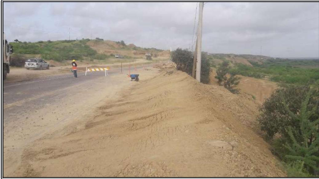
1. VISTA DE REELNO COMPACTADO DE LADO DERECHO DE TERRAPLEN CON FINES DE DIRECCONAR SALIDA DE AGUA A SALIDAS HABILITADAS CON ENROCADO.
