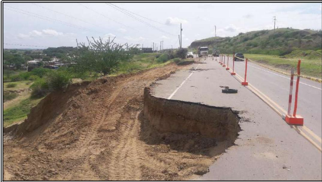
**2. VISTA FRENTE A MACACARA DE SEGUNDA DESLIZAMIENTO DE PLATAFORMA UBICADA EN PROGR. 19+530**
