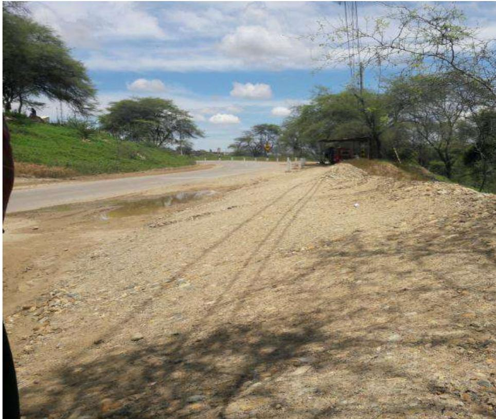
2. RELLENO DE PLATAFORMA POR DESLIZAMIENTOS POR SOCAVACIÓN Y CONSTRUCCIÓN DE DIQUE PARA ENCAUZAR AGUAS PLUVIALES.
