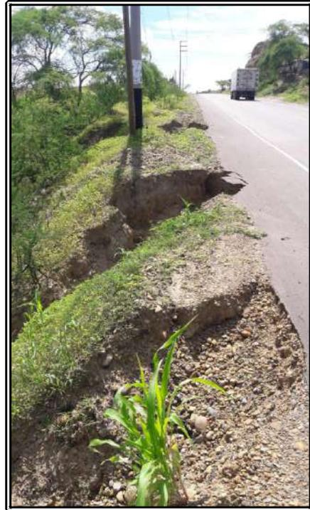
**1. VISTA DE DESLIZAMIENTO DE PLATAFORMA POR EFECGTOS DE SOCAVACIÓN DE AGUAS PLUVIALES FOTO LADO IZQUIERDO PROGRESIVA 20+100, FOTO DE LADO DERECHO PROGRESIVA 20+150.**
