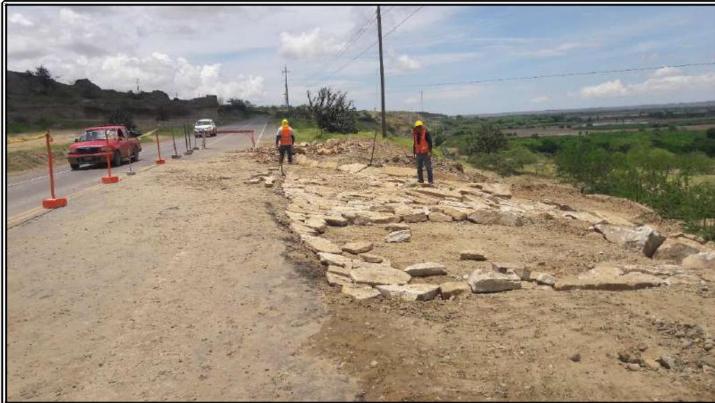
**2. VISA DE PROTECCION CON ROCA DE SEGUNDA SALIDA DE AGUA EN PROGRESIVA
