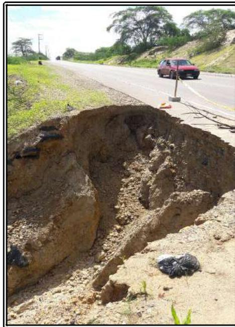
**2. OTRA VISTA DE DESLIZAMIENTO DE PLATAFORMA 20+300 Y 20+600.**
