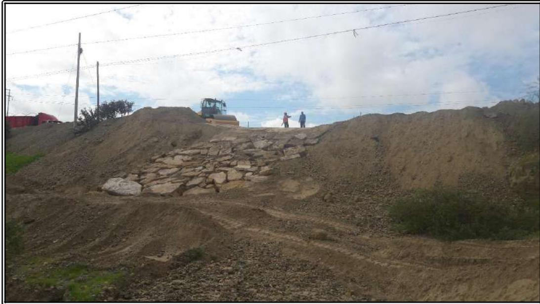
**1. VISTA RELLENO DE DESLIZAMIENTO DE PLATAFORMA Y PROTECCION CON ENRICADO EN PROGRESIVA 19+490**
