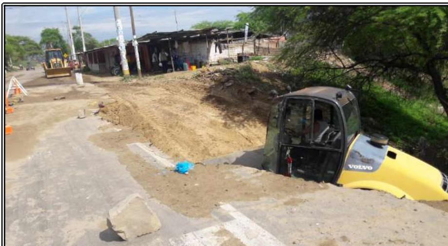
1. VISTA DE DESLIZAMIENTO DE PALTAFORMA POR SOCAVACION DE PLATAFORMA PROGRESIVA 21+100 INGRESO DE MIRAFLORES.
