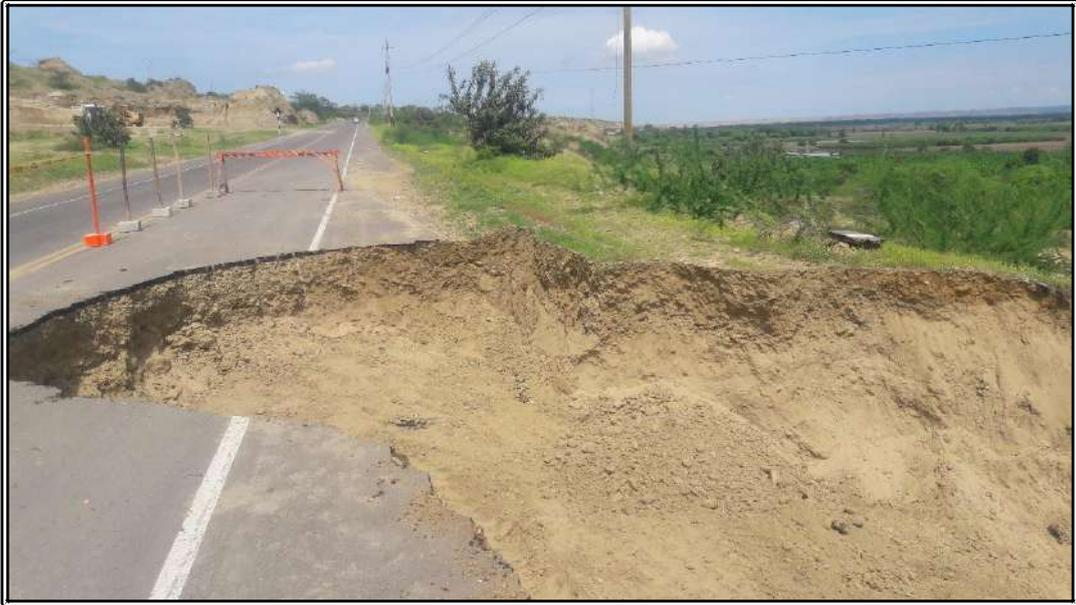
**1. VISTA FRENTE A C.P. MACACARA, SE APRECIA DESLIZAMIENTO DE PARTE DE PLATAFORMA POR SOCAVACION EN PROGRSIVA 19+490.**
