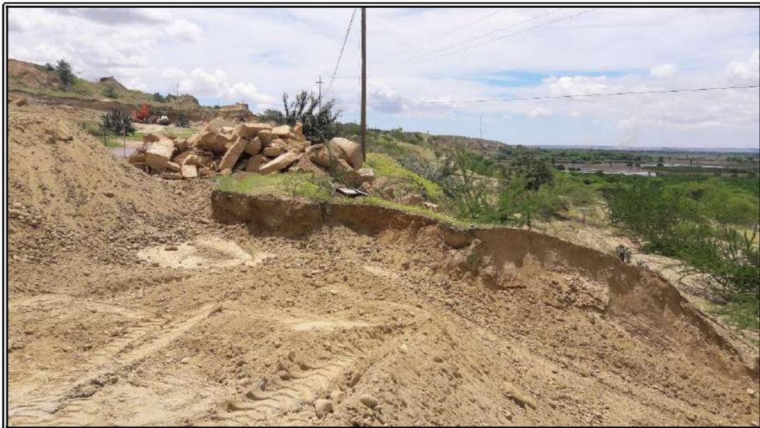
**2. VISTA RELLENO DE SEGUNDO DESLIZAMIENTO DE PLATAFORMA Y PROTECCION CON ENRICADO EN PROGRESIVA 19+530, SE APRECIA LA ROCA SUMNISTRADA A UN COSTADO QUE SERÁ LUEGO COLOCADA COMO PROTECCION DE SUPERFICIE DE TALUD.**
