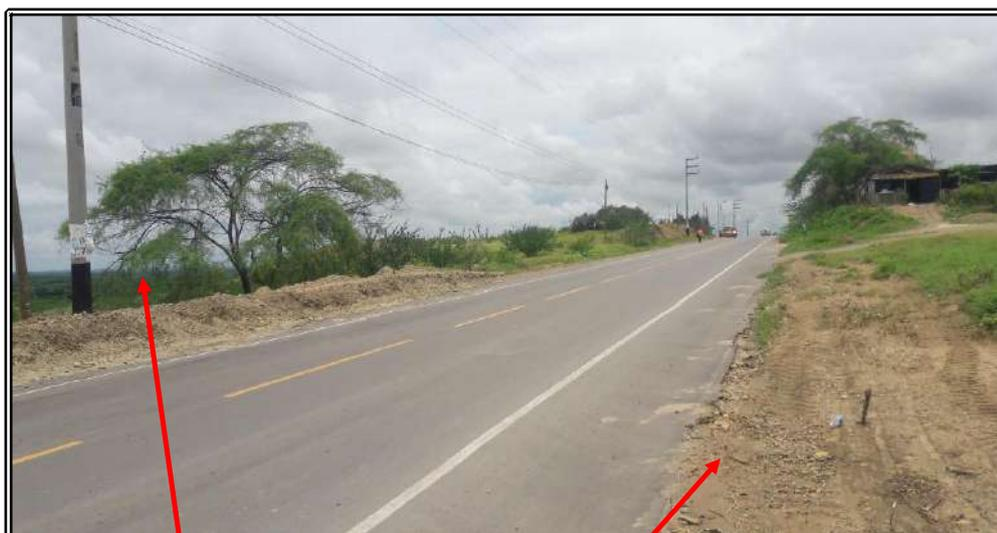
2. VISTA DE RELLENO DE DESLIZAMIENTO EN LADO DERECHO DE VIA CON ELEVACION DE TERRAPLEN PARA ENCAUZAR AGUAS PLUVIALES Y LADO IZQUIERDO CONSTRUCCIÓN DE RECONSTRUCCION DE CUENTA.
